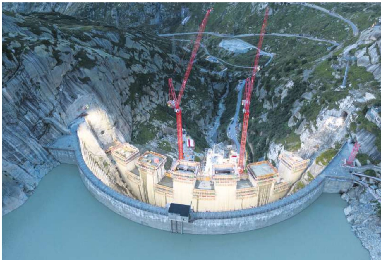
Vor der alten wächst die neue Staumauer Spiallamm empor. Inzwischen hat sie fast ihre endgültige Höhe erreicht (Aufnahme vom Sommer 2023).
